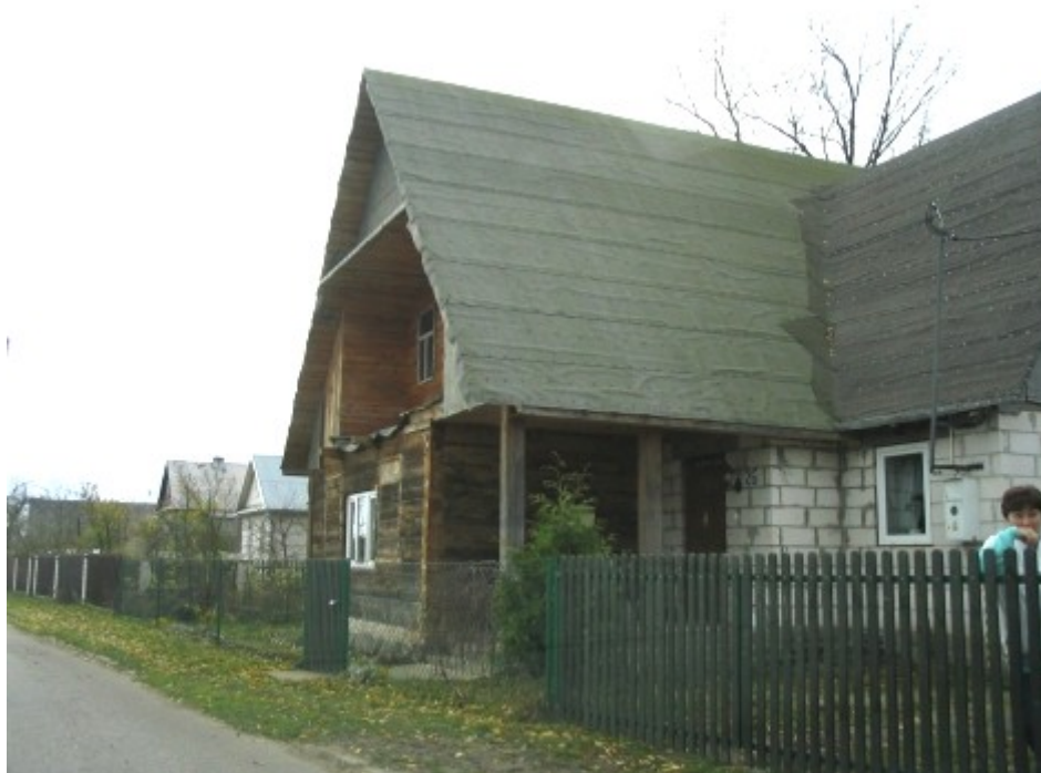
„Rozbudowa” (dobudowa części murowanej ) starej chałupy konstrukcji drewnianej.
