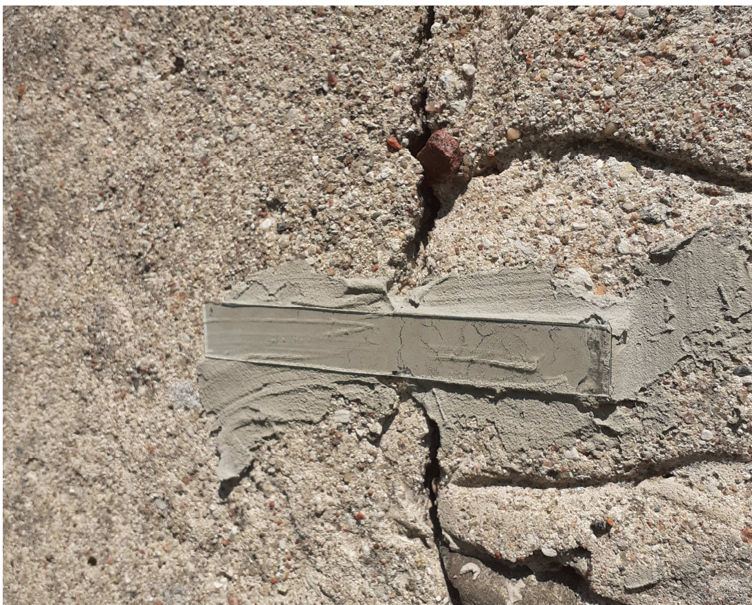
Fot.5. Szkiełko kontrolne, widoczna mikrorysa w zaprawie mocującej.
