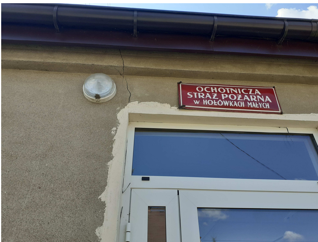
Fot.6. Widok rysy nadproża otworu drzwiowego.
