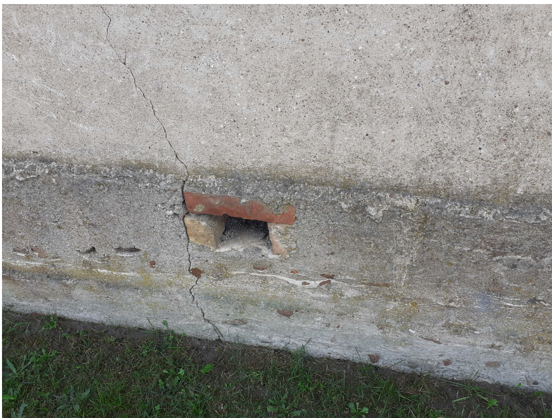
Fot.8. Widok rysy ściany i fundamentu.
