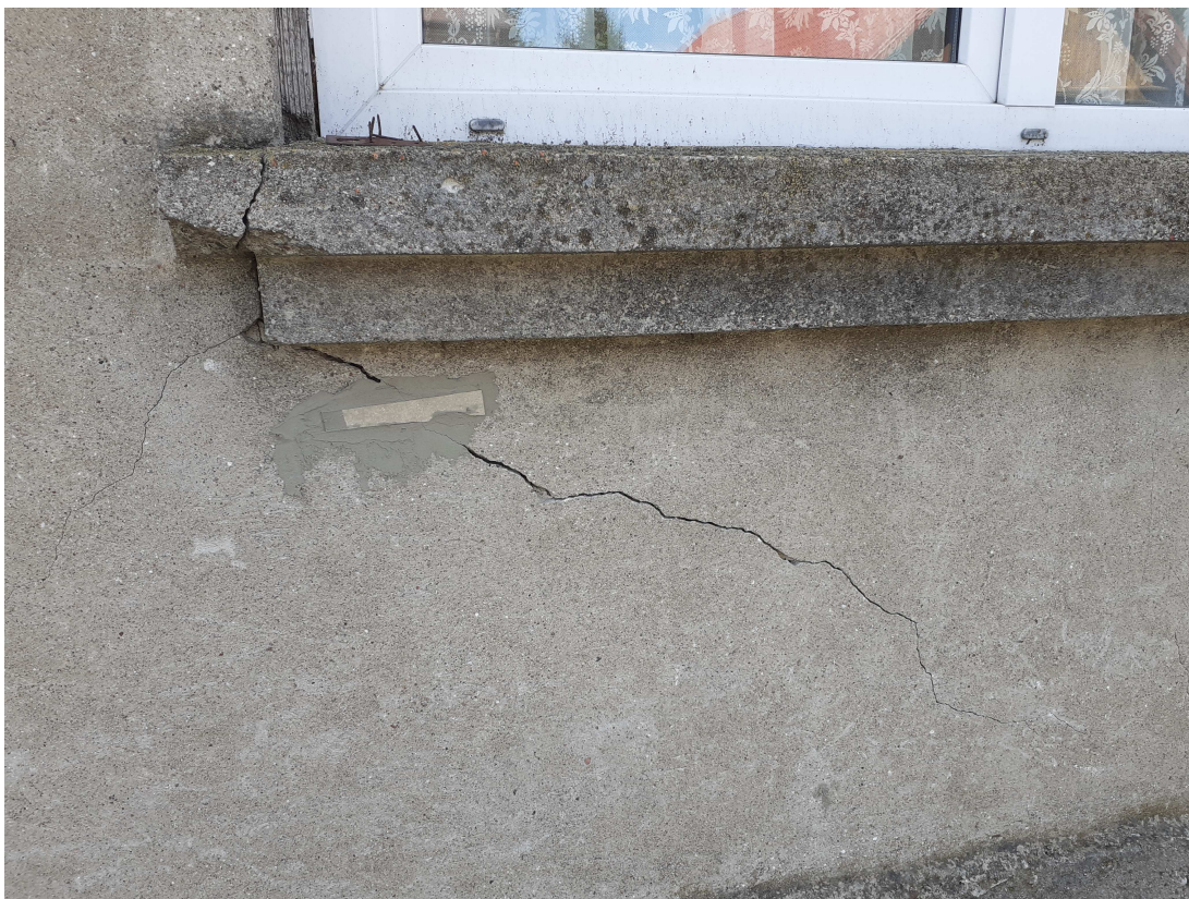
Fot.7. Widok rysy w ścianie podokiennej.
