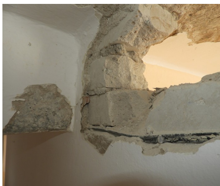
Odkrywka Nr 2 – podciąg i ściana korytarza
