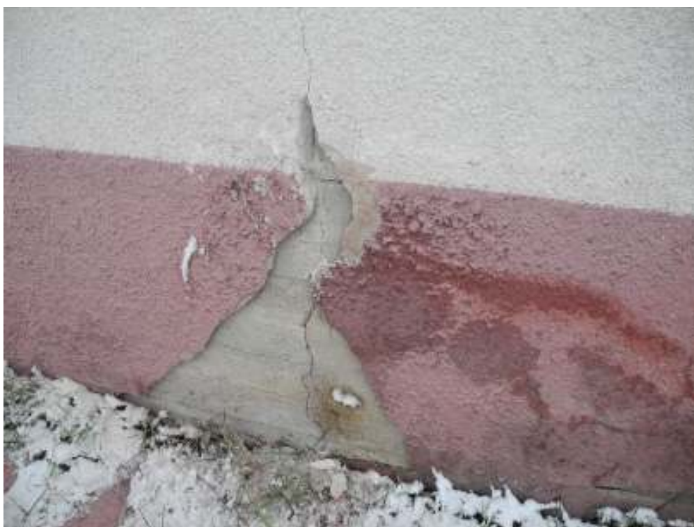
Zdj.7 Widok pęknięcia ściany fundamentowej
